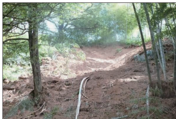
图 5 小容—东坞边坡坡面冲蚀照片
